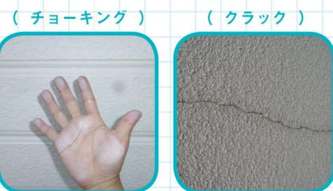
(チョーキング) 表面を手でこすったときに、チョークのような白い粉がつかれます。塗料の劣化により起こる現象で、外壁の防水性が損なわれています。
