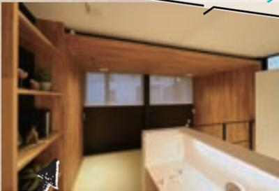
日射取得を最大にするために大きな窓を設置したので冬の暖房効率が上がる。また「潜熱蓄熱材」を天井に入れることで、冬は昼間にためた熱を夜間に放出して室温が安定するという効果もある
