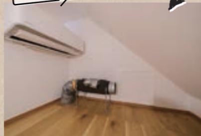
小屋裏に空調室を設け、エアコンの冷暖房の空気を、2階居室と1階の洗面脱衣室に送る。エアコンの下に風力の強い「アローファン」を置き、居室に通じるパイプファンに送風して効率よく空気を循環させる
